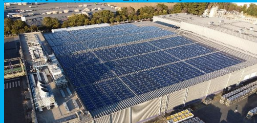
自家消費太陽光発電設置工事
