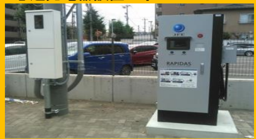
急速充電器設置工事
