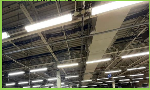
LED照明器具交換
